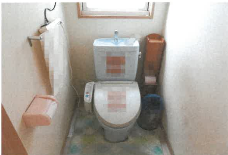
写真 2 4 物件 4 の建物内の状況
