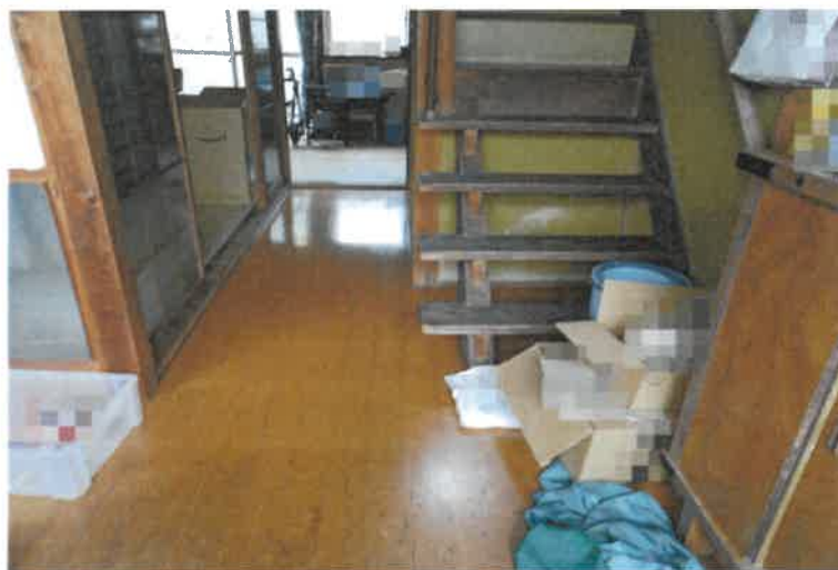
写真 5 物件 2 の建物内の状況
