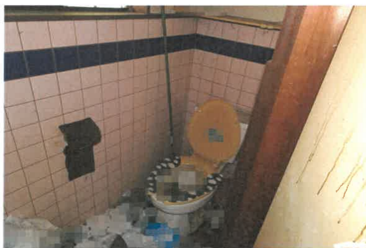
写真 2 0 主である建物内の状況
