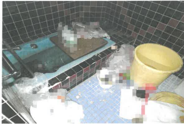
写真 1 3 主である建物内の状況
