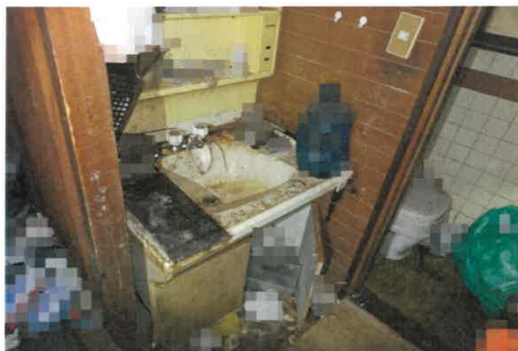
写真１１ 主である建物内の状況
