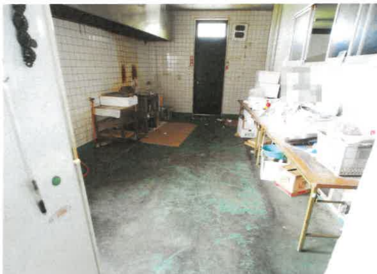
写真9 (1階南東側作業場)
