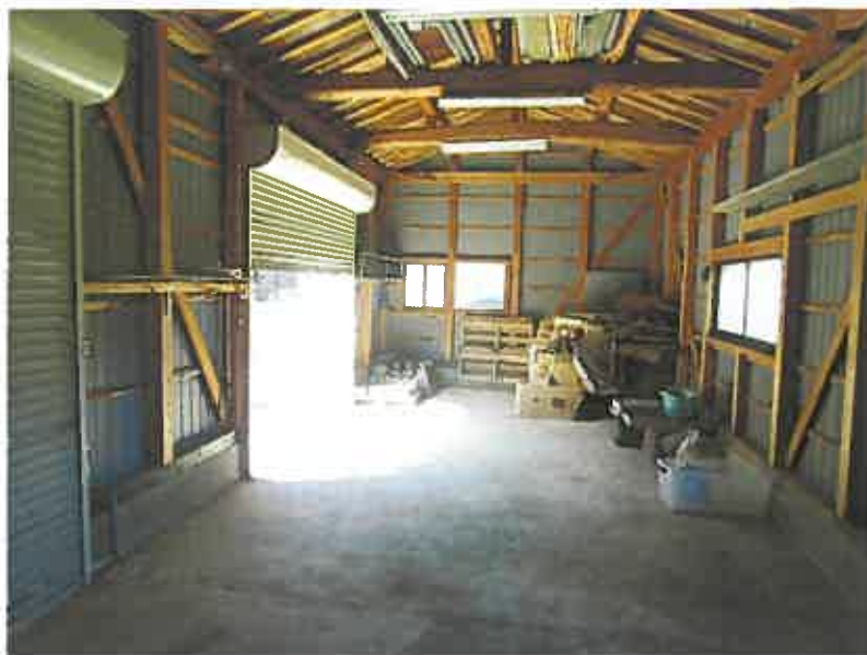
物件2 附属建物内
