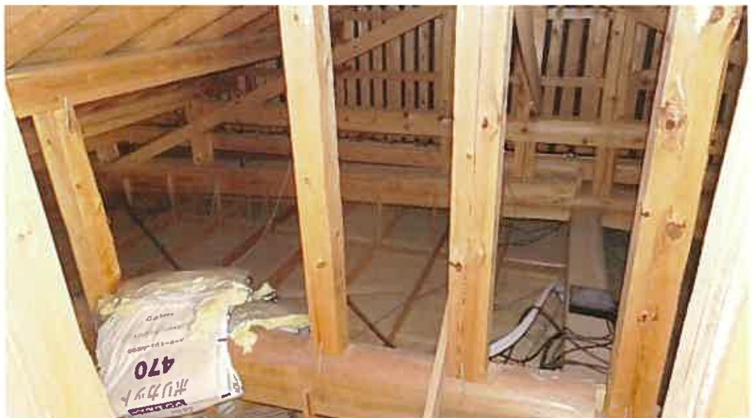
点検口からの屋根裏
