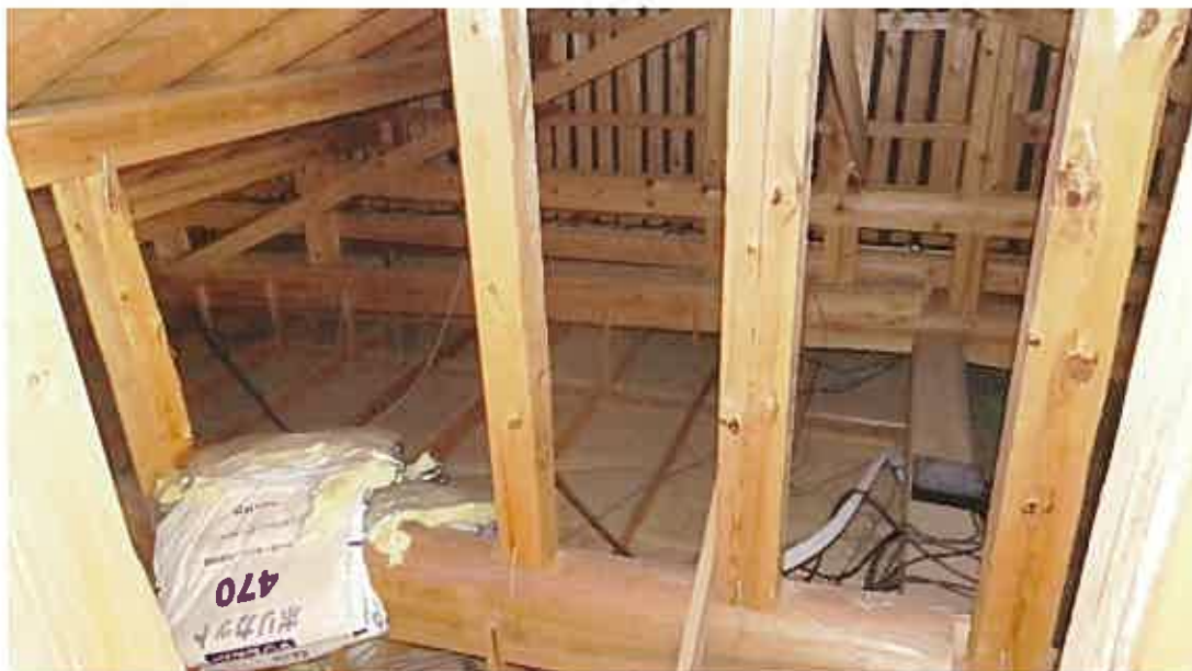
点検口からの屋根裏
