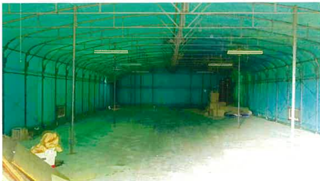
テント倉庫内部
