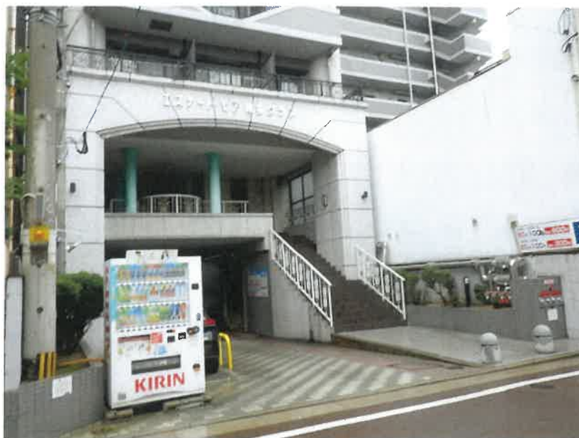
2 同エントランス付近
