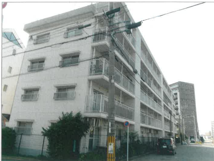
1 目的物件のある 一棟の建物の外観
