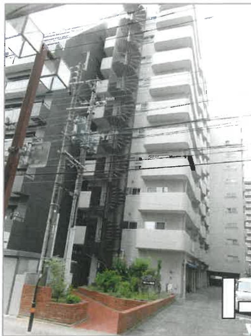
1 目的物件のある 一棟の建物の外観
