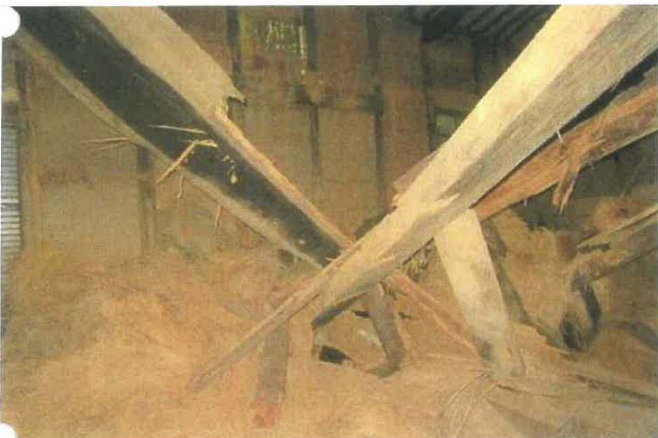
No. 14 附属建物 4 の内部を撮影
