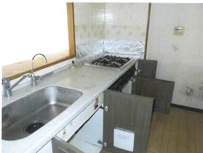
3 同(キッチン付近)
