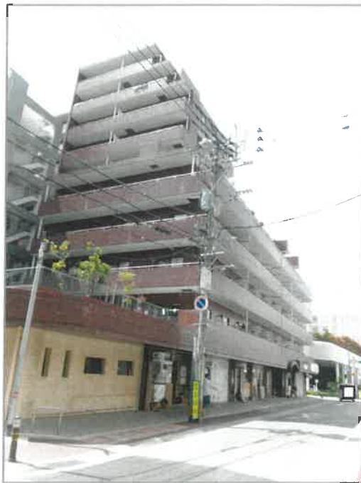
1 目的物件のある 一棟の建物の外観
