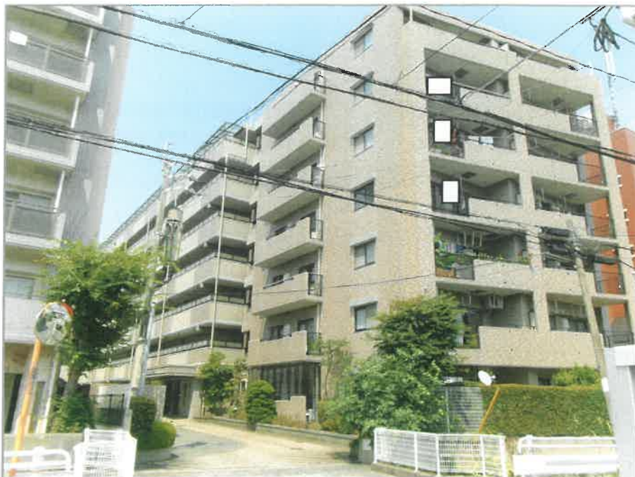
1 目的物件のある 一棟の建物の外観
