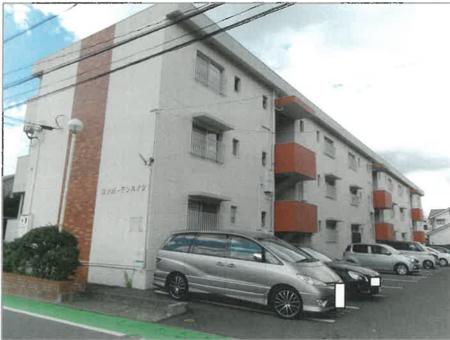
1 目的物件のある 一棟の建物の外観
