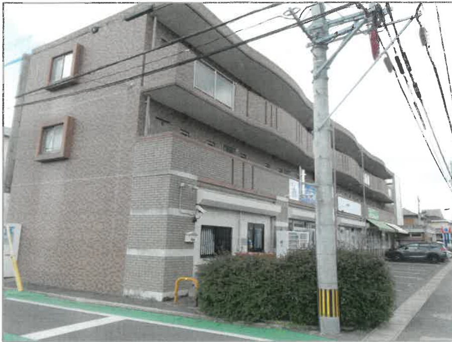
1 目的物件のある 一棟の建物の外観
