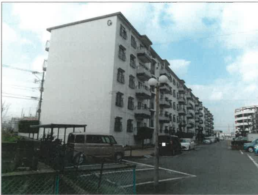
1 目的物件のある 一棟の建物の外観
