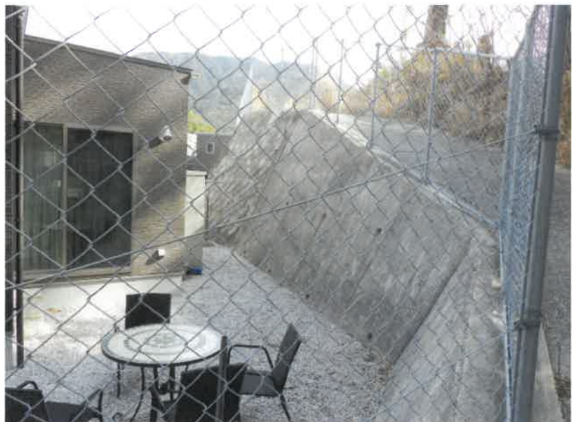
9 同西側隣地との高低差
