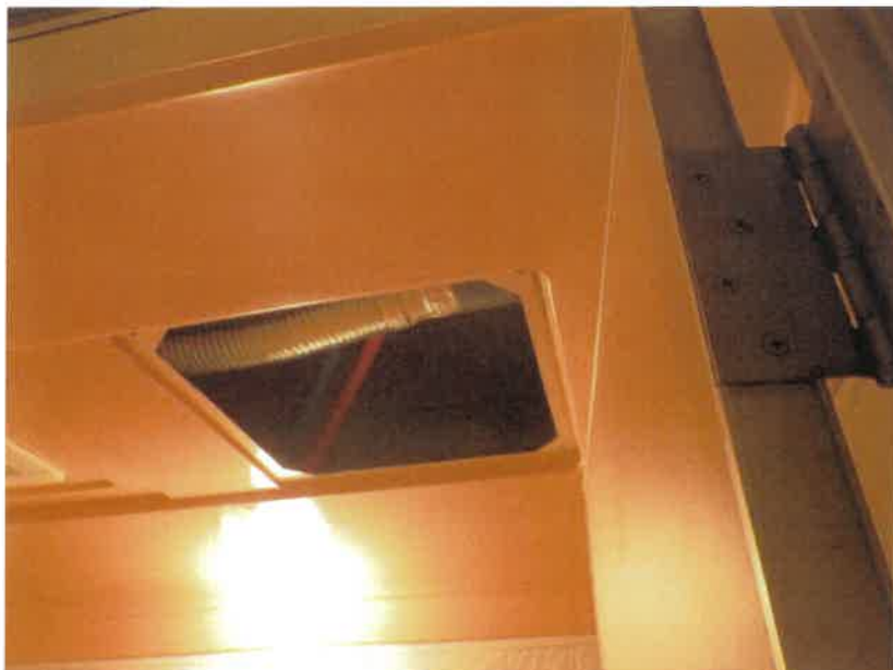
7 浴室天井の点検口 の状況
