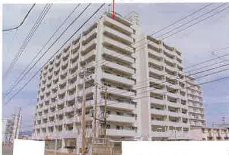
物件1 建物が存するマンション
