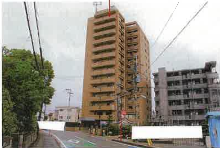
物件1 建物が存するマンション
