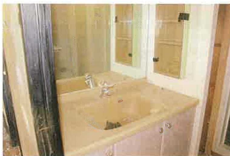
洗面・脱衣室
