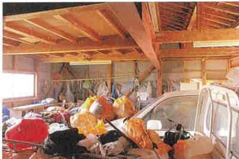
未登記附属建物内部
