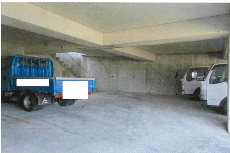
No. 12 附属建物（符号2）の内部 を撮影
