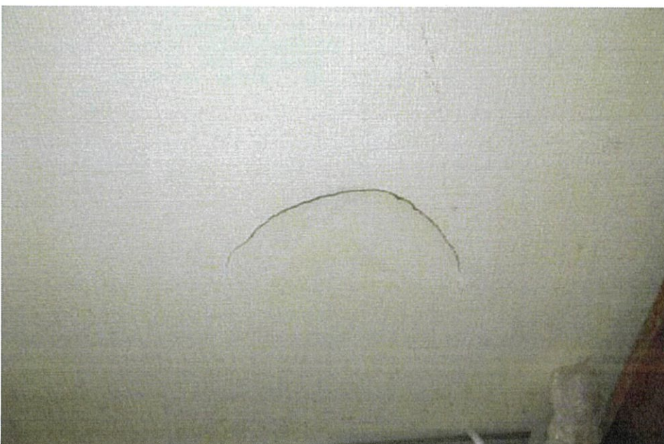
No. 9 壁の損傷等の状況を撮影
