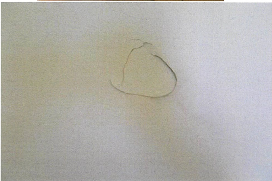
No. 6 損傷状況を撮影
