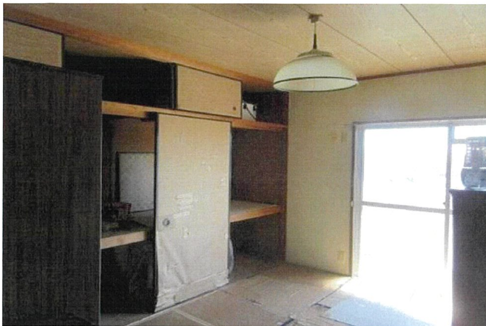
No. 4 本件建物の室内を撮影
