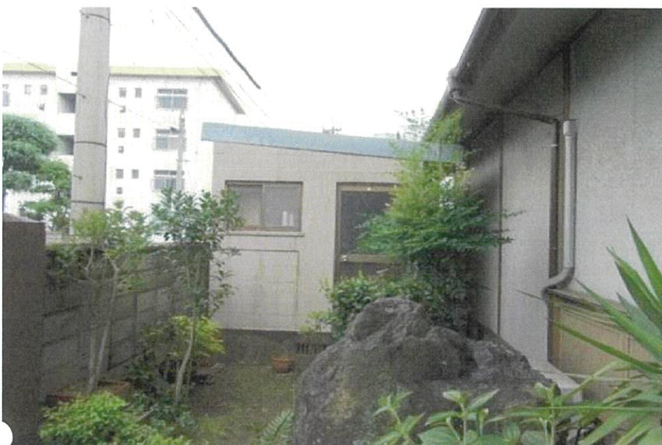
No. 8 附属建物（物置）を撮影
