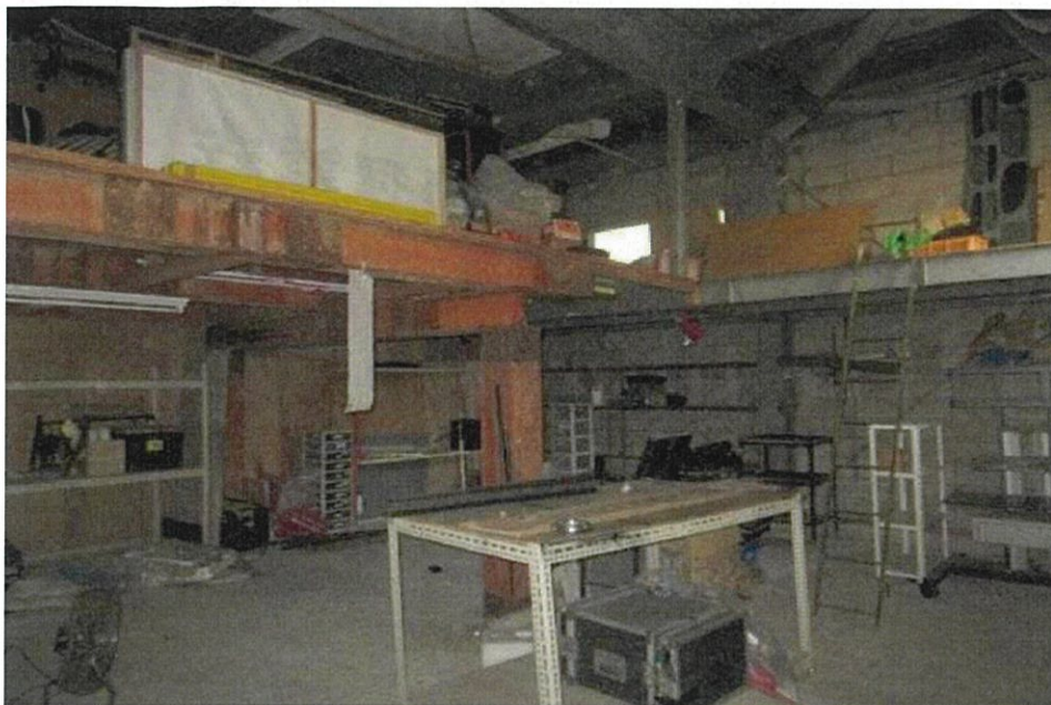
No. 4 本件建物の室内を撮影
