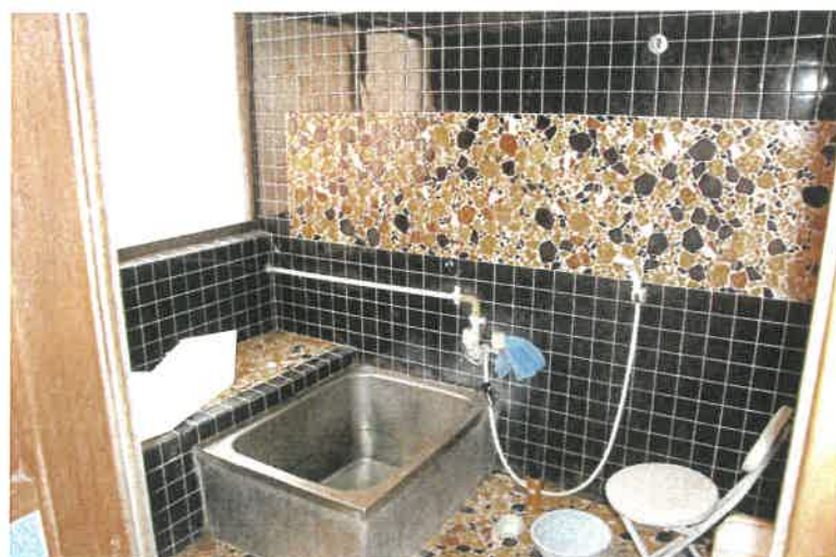
浴室 (物件3建物)
