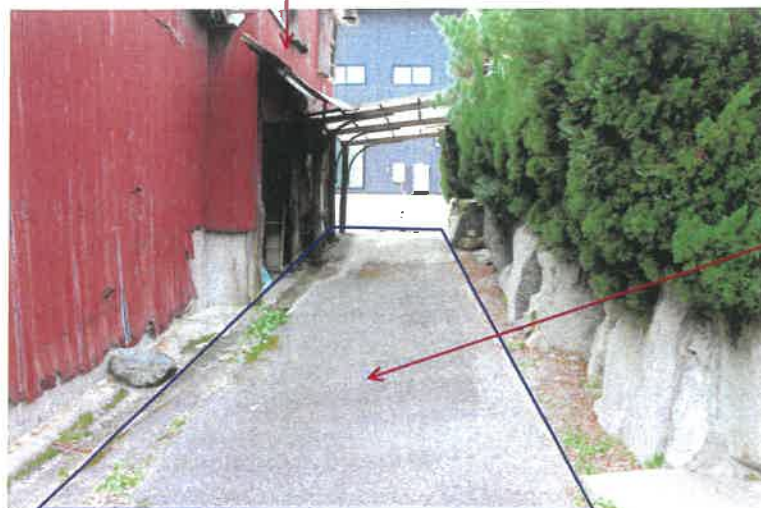
物件2建物 カーポート
