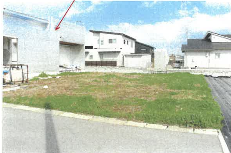
物件1、2土地上に建築中の建物
