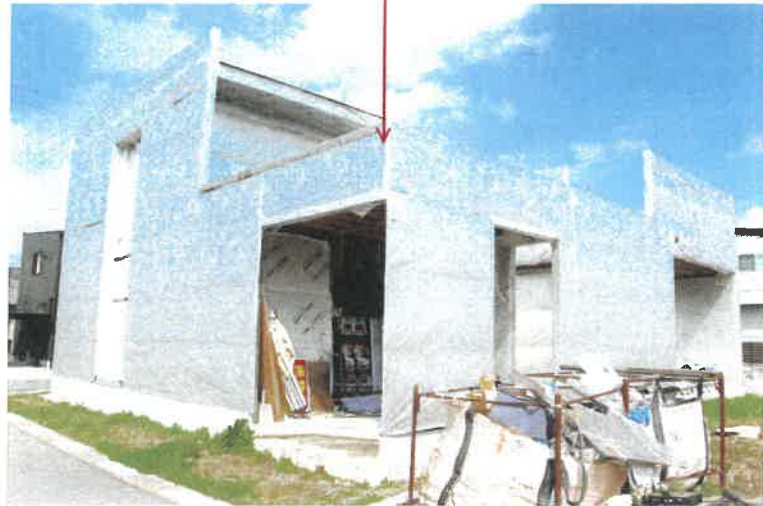
物件1、2土地上に建築中の建物
