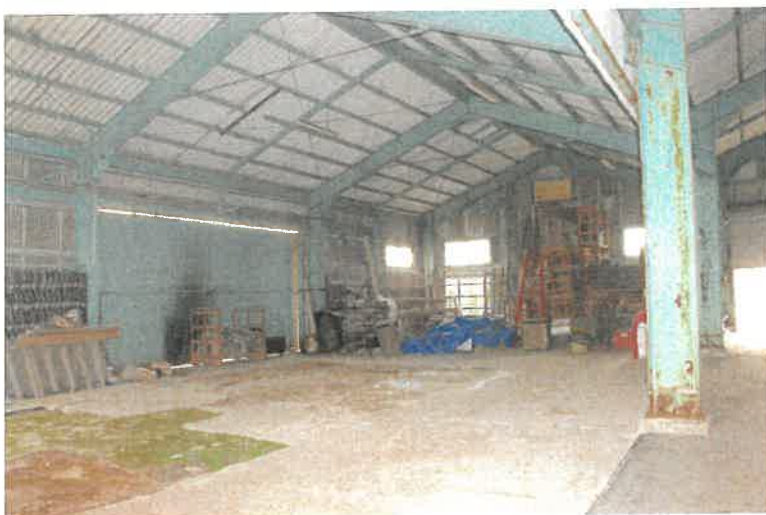
工場 (物件 4 建物)
