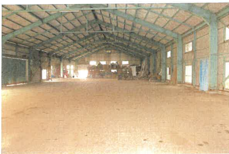
工場 (物件 4 建物)
