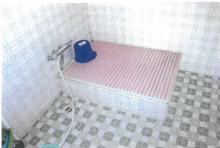
浴室（物件3建物）
