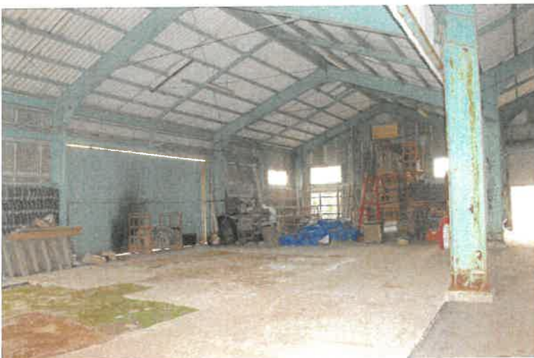
工場（物件4建物）
