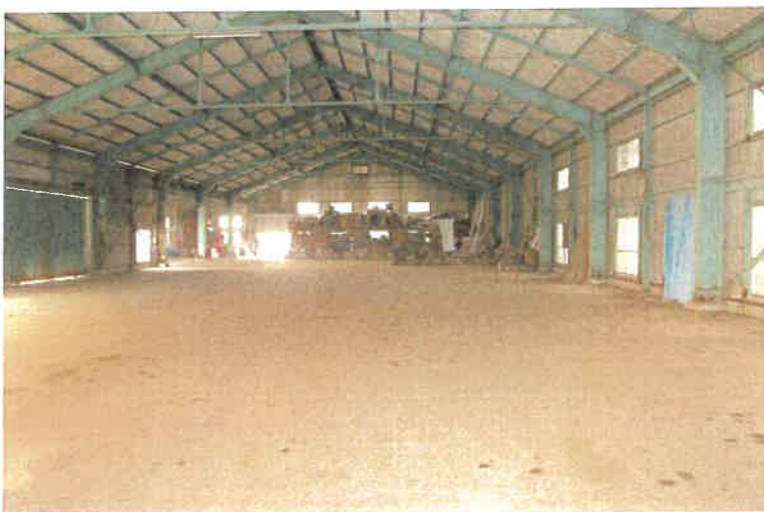
工場（物件4建物）
