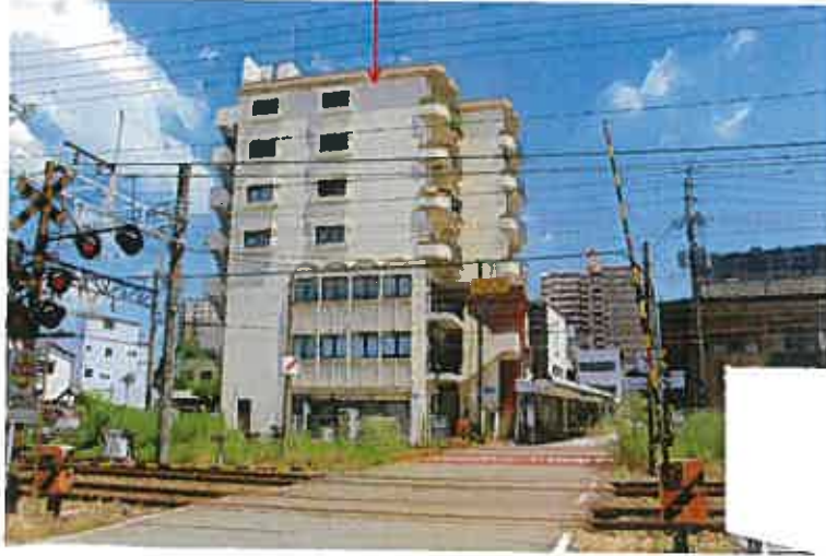
物件1 建物が存するマンション
