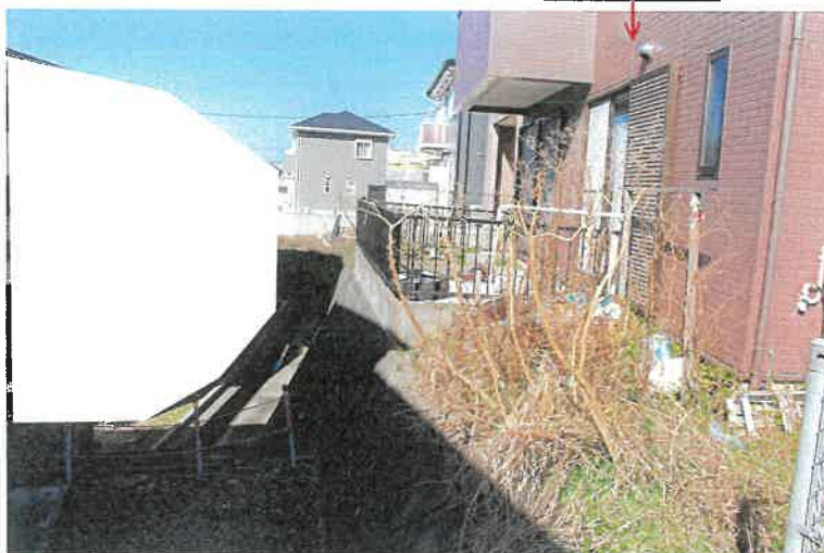
物件3 土地の擁壁の状況
