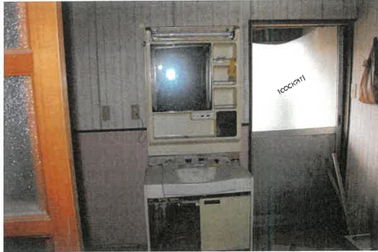
洗面所 (物件 4 建物)
