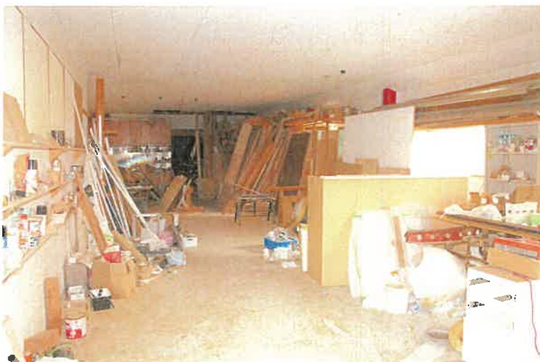
作業所 (物件6建物)
