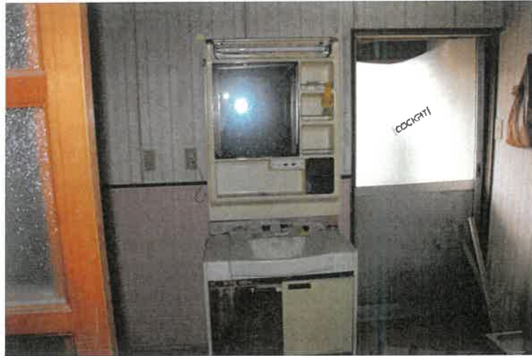
洗面所 (物件4建物)
