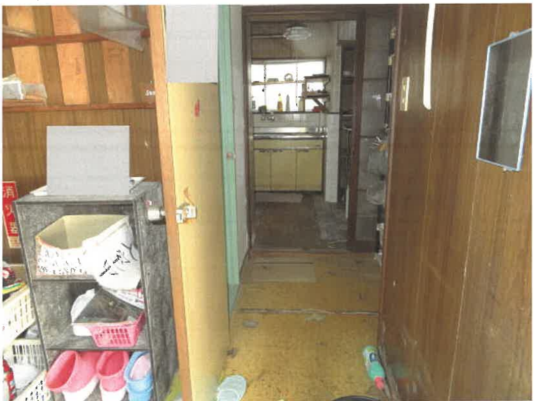
(写真 1 2) …主である建物・管理人室
