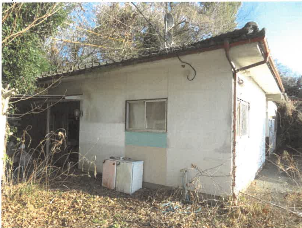
(写真1) …主である建物・管理人室
