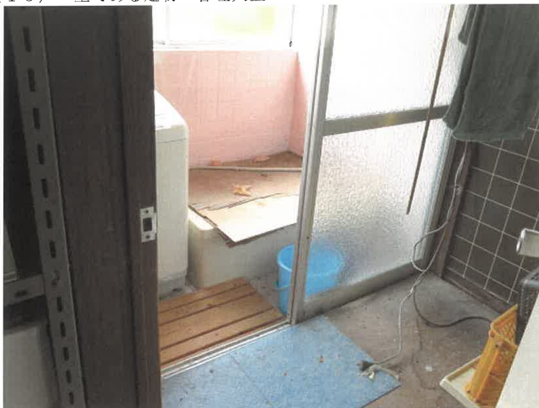
(写真 1 5) …主である建物・管理人室
