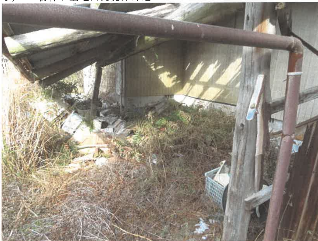
(写真9) …物件1 土地西側境界付近
