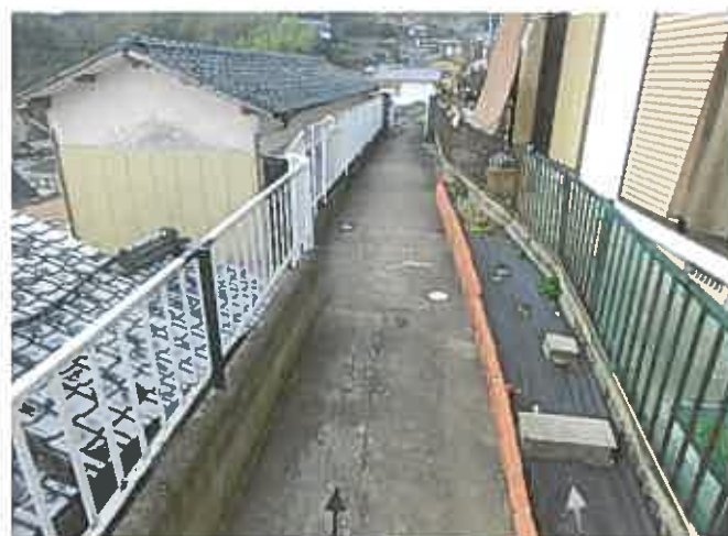
物件 3 西側の状況
