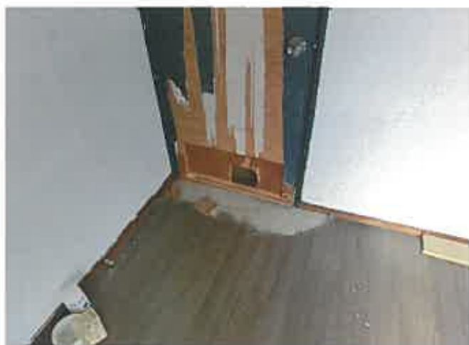
床及び建具の損傷状況
