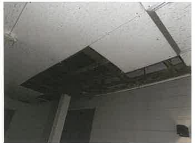
126 車庫天井の崩落状況
