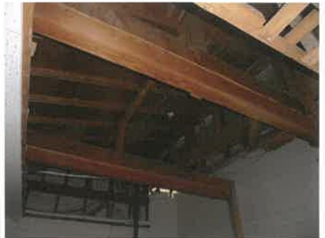
車庫天井の崩落状況
