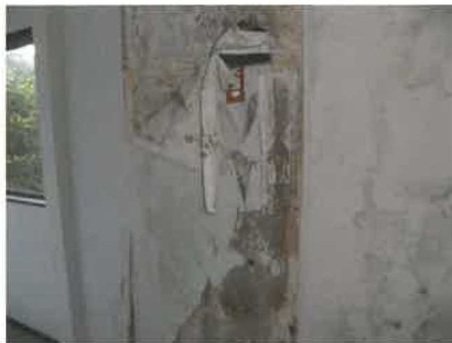
壁面の崩落状況
