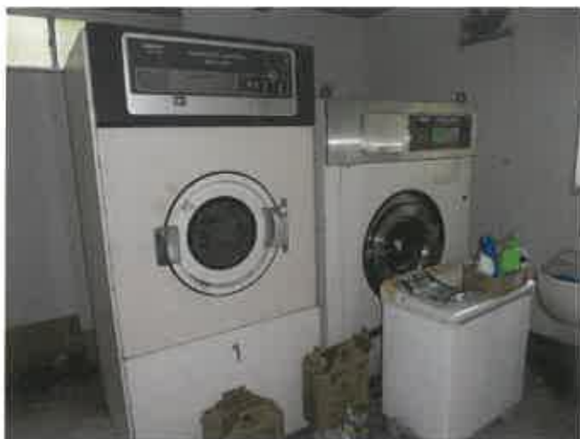
乾燥機の設置状況
