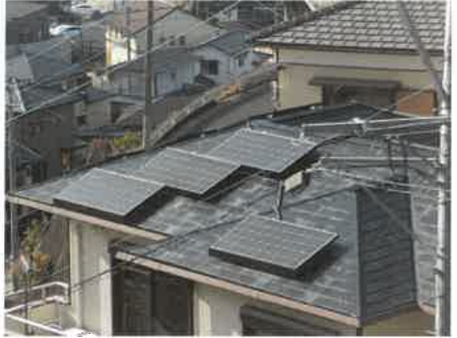
ソーラーパネルの設置状況
