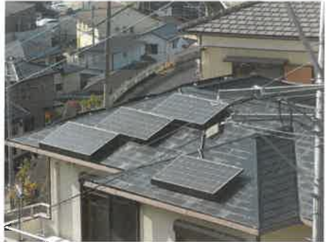
ソーラーパネルの設置状況
