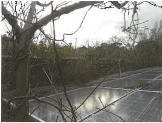
北側から1列目のパネルの設置状況
