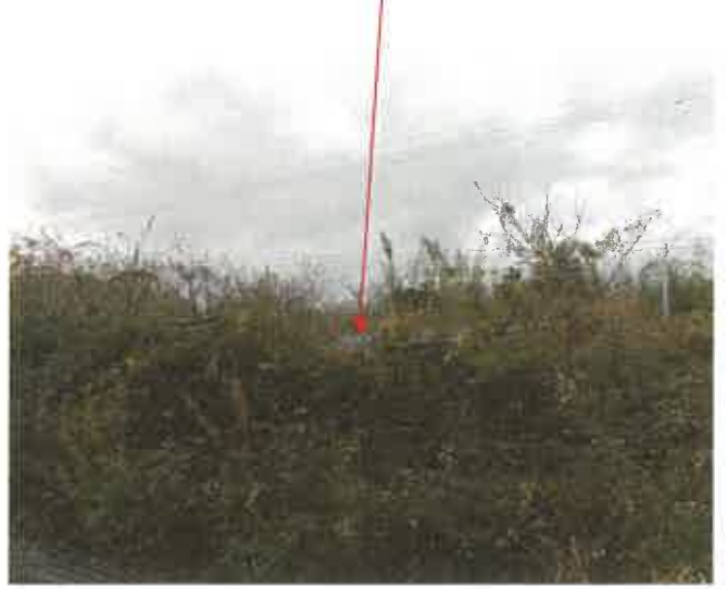
北側から3列目のパネルの設置状況
