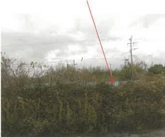
北側から4列目のパネルの設置状況
