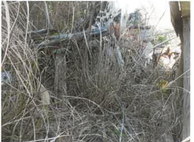
物件2符1建物内部の状況
