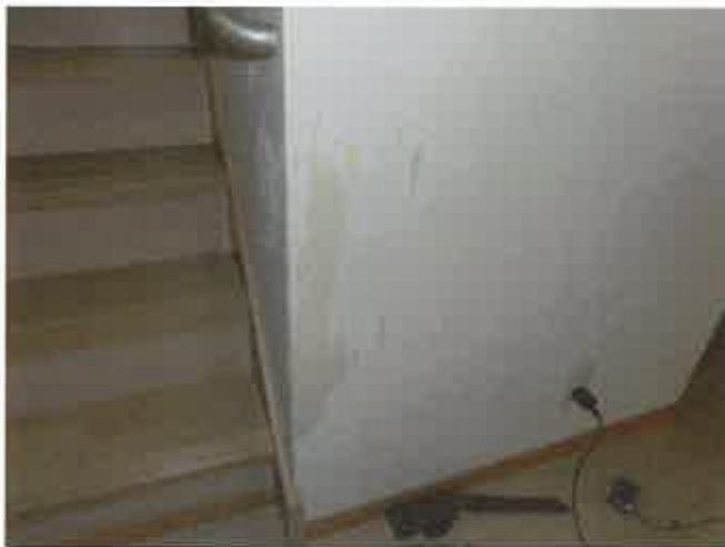
ペットによる引っ掻き疵(1 階段右横)
