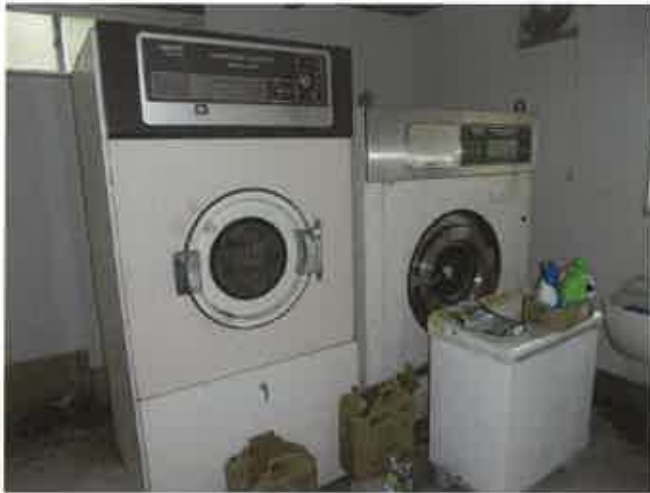
乾燥機の設置状況
