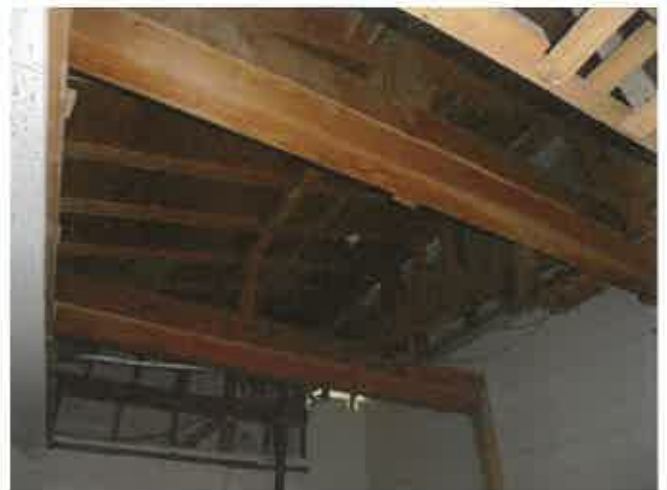
車庫天井の崩落状況
