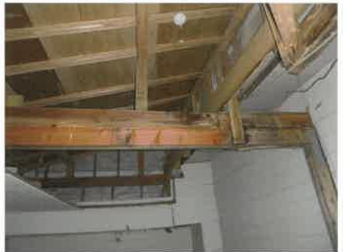
車庫天井の崩落状況
