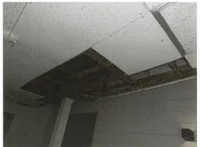
車庫天井の崩落状況
