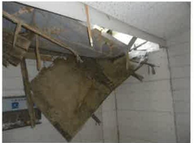
車庫天井の崩落状況
