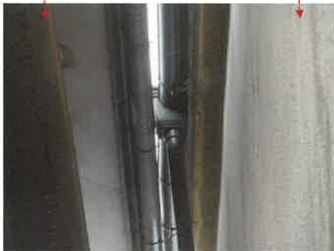
物件 2 主 軒が重なった状況 隣地建物
