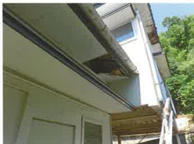
軒裏の損傷状況
