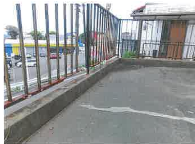
鉄柵の腐食状況
