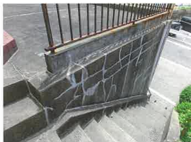
鉄柵の腐食状況
