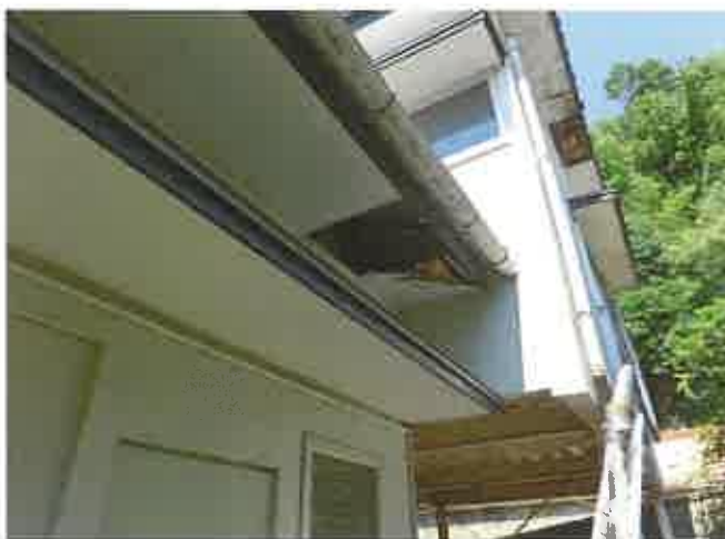
軒裏の損傷状況
